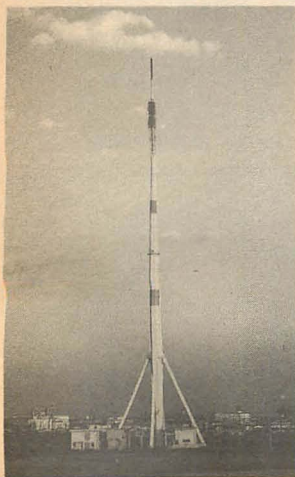
2段1面、3段2面の双ループアンテナから5kWで送信している浦和市道場の送信塔。
