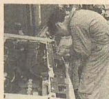
セドリックのフロントグリル内に警光灯を取付ける。この車はフロントグリルに天板があって取付けは比較的ラク。
