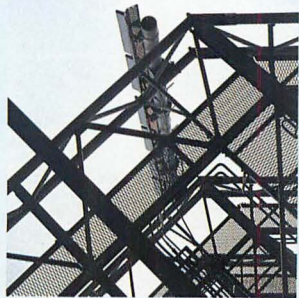
MCA アンテナ。送信・受信組で現用2本、予備1本。飛びすぎないように、指向性あり。
