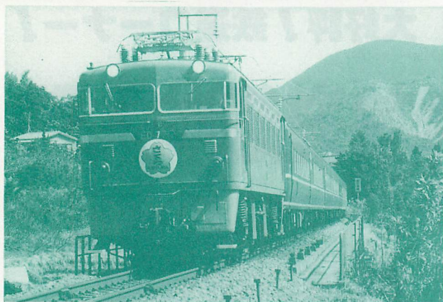
▲九州地区で標準交流電機として使われている「ED76」。Fクラス（動輪が6対）の直流電機と同等の性能を発揮しながら、Dクラス（動輪4対）で収まっているのは、交流電機だからこそのことである。
