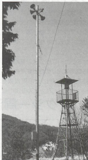
▲ 防災同報無線の鉄塔とアンテナ。
