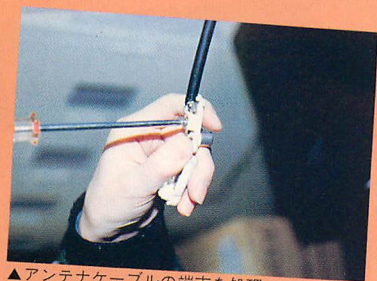
▲アンテナケーブルの末端を処理する。F型コネクタだ。
