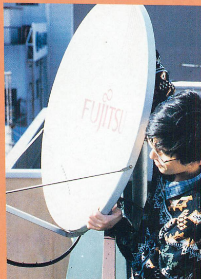
▲パラボラアンテナの向きと仰角を合わせる。
