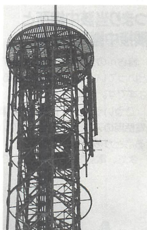
▲写真1 電話局では無指向性を確保するためにアンテナをたくさん放射状に設置しています。
