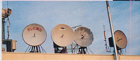
▲ターミナルビル屋上には、各テレビ局の中継回線用のパラボラアンテナが並んでいた。
