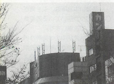
▲写真6 IDOのアンテナは一般のビルの上にあることが多いです。
