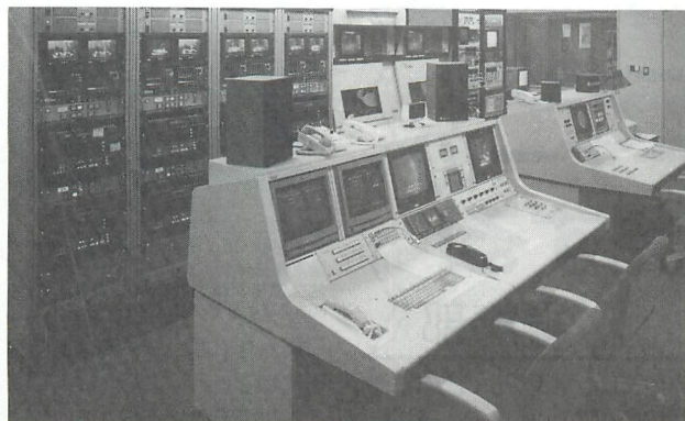
▲放送センターのVTR室。ビデオはD-2デジタルデッキだ。マスターテープはフィルムネガから起こすことにより、極めて高品位な映像を提供できる。その画質はレーザーディスクを越える、と評価されている。
