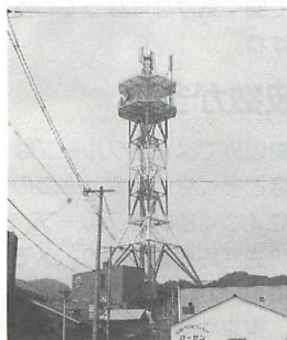
▲船との通話の船舶電話用、アンテナが大きい。
