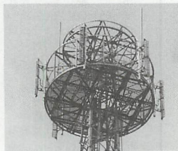
◀アンテナは放射状に設置されています。
