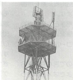
▲船との通話の船舶電話用、アンテナが大きい。
