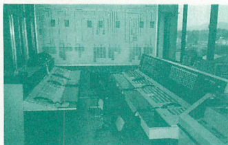
▲県庁内、消防防災課（7階）の司令卓。左が1期の古いもので右が最新の設備です。壁には無線系統図が貼ってあります。
