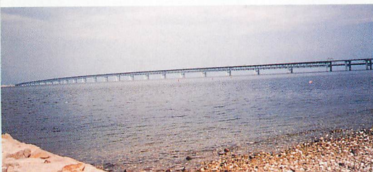
▼空港島とりんくうタウンをつなぐ連絡橋「スカイゲートブリッジR」は、道路、鉄道両用で全長は3.75km。上段が道路、下段が鉄道。
