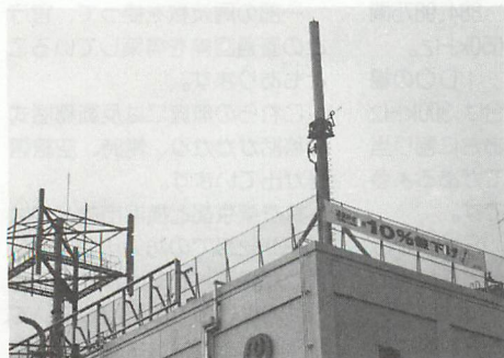
▲NTTの屋上にアンテナがあるのは当たり前。太いのが旧システム用、左が新システム用。
