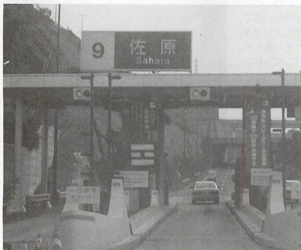
▲最近増えてきた有料道路の自動発券ゲート。一瞬にして、車の車種、高さ、重量、ナンバーを読取り、通行券発券する。ゲートでは超音波利用の高さセンサで、車の高さを調べる。
