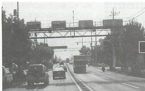
▲路上に設置される自動ナンバー読み取り装置、Nシステムも赤外線フラッシュで通過車両を照射し、カメラで車のナンバーを読み込む。
