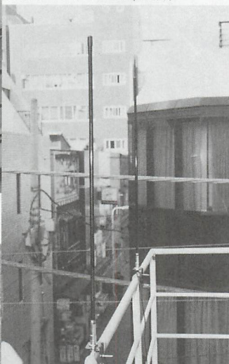
▼ベースアンテナを付けていない状態では1くらいしか振っていないかったものが、付けたとたんにフルスケールだ！
