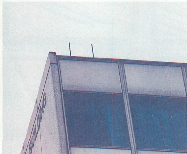
▲編集部のすぐ近くにあるアステルの基地局。ビルの屋上にカタツムリの目みたいに飛び出ているのがアンテナ（2本1組）。設置はかなり前に済んでいたのだから、ようやく電源が入ったということらしい。2月26日より稼働。
