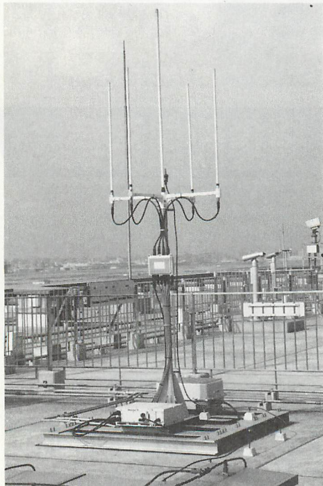
▲羽田空港で見つけた3社の基地局を比較。DDIポケットは5本タイプのアンテナ。一番目立つ。工事は文句なし。
