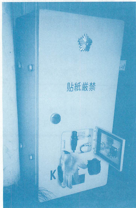
▲道路の信号機近くに設置されている制御箱。開いている部分から見えるのはリモコンユニットらしい。
