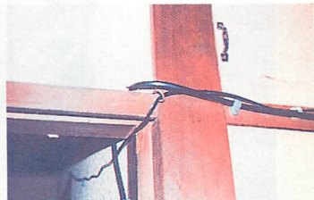
▲家によっては壁に穴を開けて通します。いままでのケーブルの穴を流用しました。細いのは電話線です。
