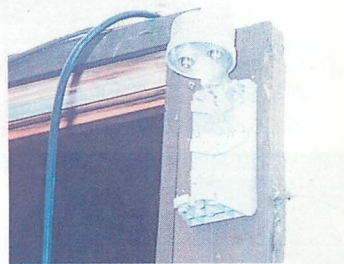
▲家庭に電流の異常流入を防ぐ安全器が取り付けられます。ケーブルに雷などの誘導電流が流れてもテレビを保護します。
