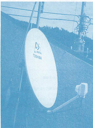
▲写真-7 Uボルトでがっちりベランダの手すりパイプへ止めたので風にも強い。
