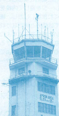
▲航空機は地平線の向う側の高高度から接近してくるので空港のアンテナは指向性が地平線方向に感度が鋭いディスコーンアンテナが多用されるのです。
