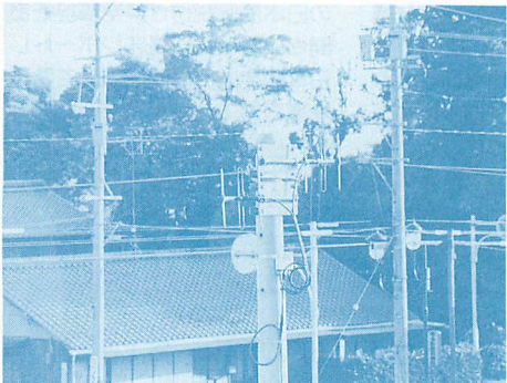
▲Cタイプの電波は最寄り駅のこんなアンテナで受信され、返事を送信する。
