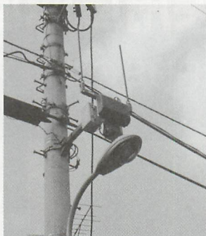
▲NTTパーソナル20mW基地局アンテナ。首都圏には13万局設置されている。
