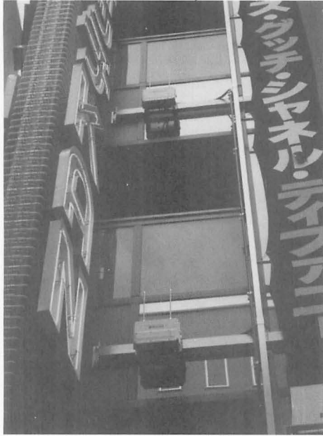
▲DDIポケットの場合、アンテナが複数設置されることは珍しくない。
