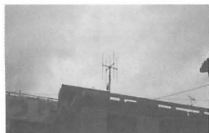
▲これもNTTパーソナル500mWアンテナ。通話品質はかなりアップしてきているはず…。
