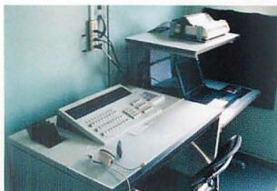
▲JFTC/24 航空自衛隊で使用されている電話交換機で、平成3年度あたりから導入されています。手前にあるのが電話中継台、奥のノートパソコンは交換機の保守コンソール、上はプリンターで保守コンソールの内容をプリントアウトです。中央部は、交換機の配線板。右は、交換機本体。交換機本体の中には回線パッケージ
