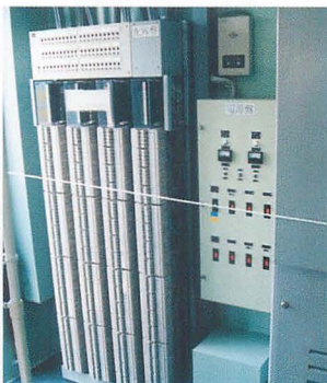
▲JFTC/24 航空自衛隊で使用されている電話交換機で、平成3年度あたりから導入されています。手前にあるのが電話中継台、奥のノートパソコンは交換機の保守コンソール、上はプリンターで保守コンソールの内容をプリントアウトです。中央部は、交換機の配線板。右は、交換機本体。交換機本体の中には回線パッケージ
