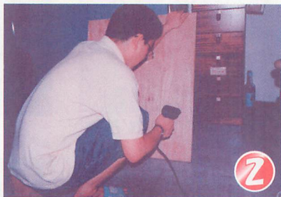
▲ 基台をボルトで止めるための穴を開ける。
