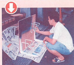
▲マスコンとブレーキを固定する操作台を運転台にあった色に塗装。
