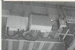
▲写真4 500mW駅構内タイプ。基地局本体が大きいので他キャリア基地局よりかさばって見えた。
