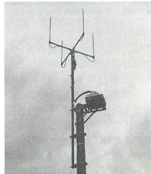
▲写真3 500mW自立柱タイプの現行バージョン。箱型の基地局本体が一つにまとまったタイプ。
