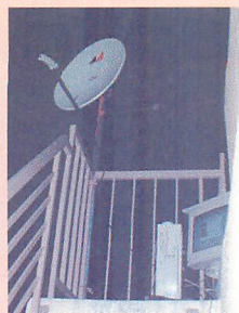
▲屋上にパソコンを上げて、モニタを見ながらアンテナ角度調整した。
