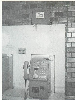
▲写真16 公衆電話の上部に箱型アンテナが…。基地局本体は電話機の下に設置されていた。
