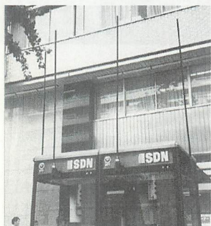
▲写真6 電話ボックスに2台(アンテナ4 本)設置された20mW多回線型基地局。
