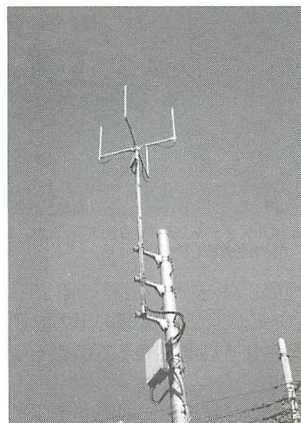
▲500mWアンテナをメインに、着実にエリア整備を進めるDDIポケット。これに無瞬間ハンドオーバー端末が投入されれば…。
