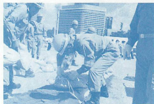
▲水防工法訓練 淀川が決壊したとの設定で土嚢を積み本当に堤防を制作。
