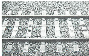
▲一面に敷き詰められたバラスト。交換されたばかりなので、まだ色が白い。
