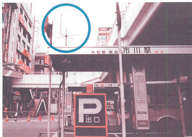
▲AVMの電波はバス停の上のアンテナで受信して指令所に送られます。
