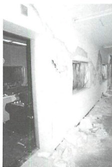
◀震災当時の社屋内の様子。壁ははがれ、鉄筋が見えているのがわかる (写真提供・ラジオ関西)。
