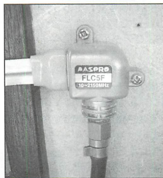
◀室内側は、そのまま壁にネジ止め。
