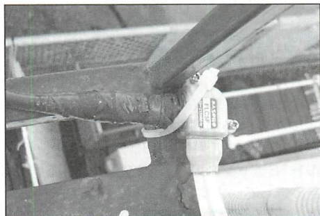
▲隙間ケーブルの自己融着テープは、自分で巻く必要がある。
