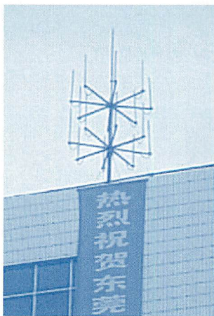
▲写真8、9：中国版PHS「小靈通」の2段型8本アンテナ。日本国内で導入されている高度化PHS対応ではないと思われるが、移動体通信の中ではかなり変わった形状の部類に入る。アンテナの中心に伸びるのはやはり避雷針だろうか？（撮影：熱烈ファンさん 画像提供：skynetさん）
