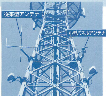
▲写真4: 周辺をカバーしている従来型アンテナ(左)と隣接するエントランスアンテナに向けて電波を中継している小型パネルアンテナ(右)。下部に取付けられた箱型アンテナが向けられた先にはベース局が存在するはずだ。
