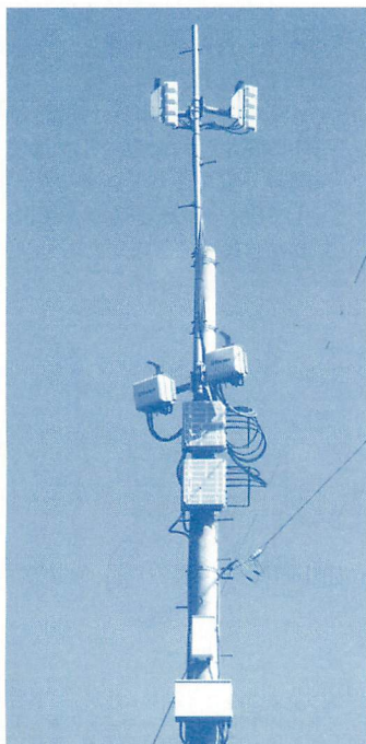
▲写真5: サービス圏外地域に建てられている無線エントランス回線中継局。DDIポケットの数あるアンテナ局の中でこれほど希少性の高い局はない。従来型アンテナのないその容姿はかなり異様だ。
