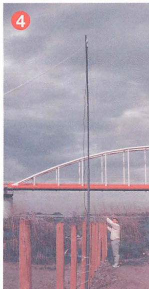
▲上がったエレメントを斜めに延ばして固定します。左右の張りを調節します。
