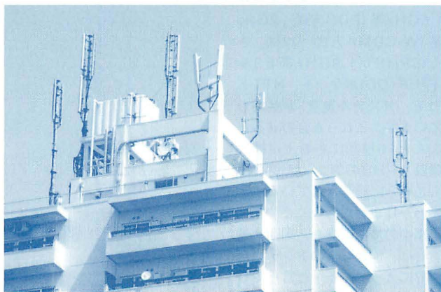
▲マンション屋上に設置された移動体通信アンテナ群。街中を歩くと建物上に様々なモバイル通信アンテナを目にすることができる。
