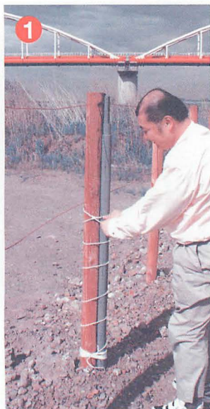
▲河原で杭があったのでそこに伸縮マストを沿わせて建て、根元を固定します。
