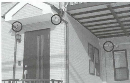
▲2003年10月号で構築した、TELSTAR WJ-500を使ったセキュリティシステム。○印内の3台のカメラを設置したが、今回はさらに1台増設して、MPEG4記録システムを導入する。
