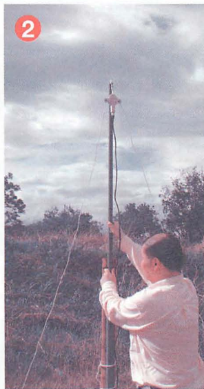
▲給電部はあらかじめつくっておき、伸縮マストにかぶせて長さを足します。そして各パイプを伸ばしていきます。
