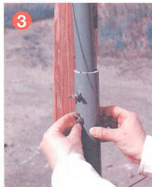
▲貫通穴を合わせ、ボルトを通して蝶ナットで固定します。これならブライヤー1本で締められます。
