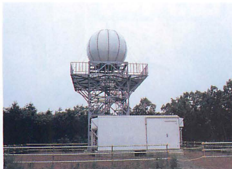
▲雲の中の風向風速も求めることができる出力200kWの「気象ドップラーレーダー」。
