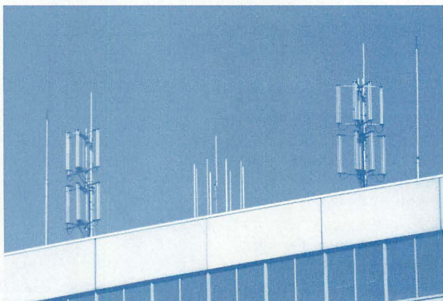
▲つい最近確認された高感度指向性アンテナの2段式アンテナ(左右2基併設)。これは今までにはなかった新しい設置方法だ。8本アンテナ(中央)も設置されているのが確認できる。人口カバー率100%を目指すと共に都心の高度化PHS対策も着々と進められている。
