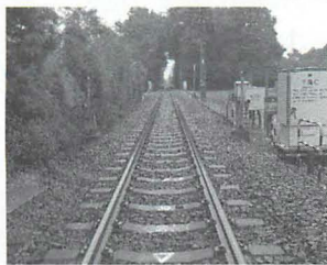
▲日本の「標準軌」は1,067mm幅。世界的にみると「狭軌」となる。本当の「標準軌」は新幹線や一部の私鉄に採用されている1,435mmだ。
