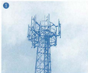
▲アングルトラス式のPDC、W-CDMA併設局。ボーダフォンでは既設PDC局にW-CDMA局を追加設置していくのとは別に、マイクロ局などできめ細かいエリア構築を進めているようだ。
