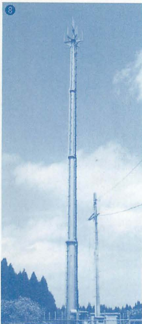
▲頂部アンテナ群。PDC用6本(2×3)とW-CDMA用2本(2×1)。首都圏では見ることのできない珍しい設置である。 ◆併設設置例2。鋼管柱タイプの併設マイクロ局。高さ約40～50m。
