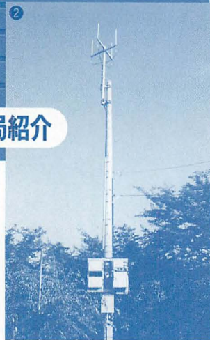
▲PDC単独アンテナ。支柱下部に確認できる基地局ユニットはこれでアンテナ1組(2本)分。もう1組分の基地局ユニットは支柱の反対側に設置されている。
