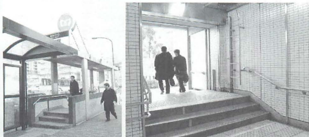
▲海抜0m地帯にある地下鉄駅は、簡単に水が入ってこないように、階段を高くしている。水かさ増したときには防水壁を設置し食い止める。それでも食い止められない状態の時は、防水扉を閉めて対処する。写真は共に東京メトロ木場駅。ふたつある入り口の方(右)には、完全に水没したときに備え、入り口屋根に出られるように、非常梯子が付けられている。
