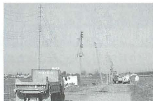
▲新潟県中越地震ではこのように電線がたるんでしまった。しかし断線しなかったことで復旧もスムーズに行えたようだ。断線・寸断が大量に発生したら情報のライフラインの復旧にはかなりの時間がかかることになる。耐震電柱架線を研究開発する必要があるだろう。
