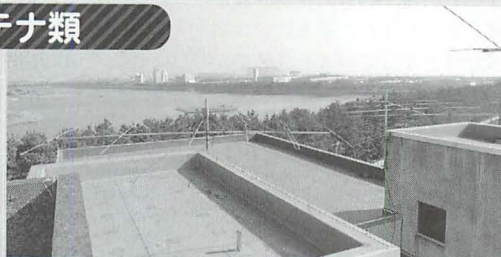
▲4方向にそれぞれ設置されている6エレメントの八木アンテナ。右が北、左が東を向いている。奥に見える水場は「市川野鳥の楽園」だ。
