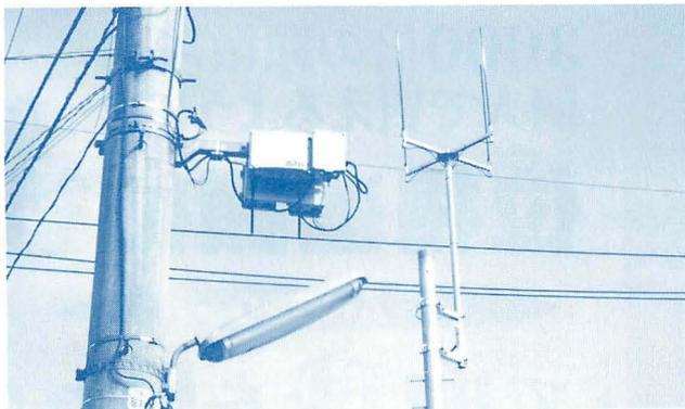
▲ドコモPHSの500mWアンテナ(右奥)と電柱に設置されているアステルアンテナ(左手前)。両キャリアはPHSにどのような思いを持って事業を続けてきたのだろうか…。
