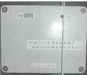
▲これがブレーカー遮断機の外部。リセット用の紐が出ているだけのシンプル構造。
