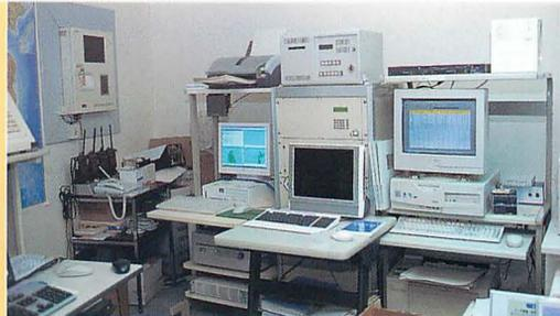
▲自動放送される防災行政同報無線の装備は、地震計（左奥壁）と緊急情報衛星同報受信装置（左の液晶モニター）を、防災無線と組み合わせて構成されている。現在は無線だけでなく、メールも同時に配信される。
