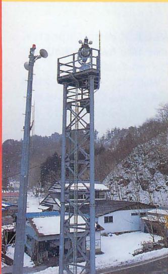
▲田老港脇に設置されている津波監視用テレビカメラと防災同報無線のスピーカー。テレビカメラの映像は、録画をWebに公開している。同報無線スピーカー49局設置され、気象観測テレメータも備えられている。
