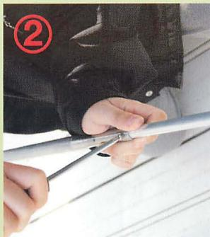
▲2段目、3段目のジョイント部分はタッピングビスで固定する。
