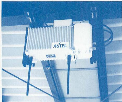
▲アステルの20mW小出力アンテナ設備。同社とドコモPHSは大出力アンテナの開発が遅れ、それが後々、大出力アンテナがメインのDDIポケット（現ウィルコム）のエリア拡大に追いついて行けないジレンマに陥ることになる。
