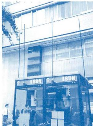
▲NTTの公衆電話ボックス上に設置されているドコモPHSの20mW小出力アンテナ。PHSはマイクロセル方式のため、このようなアンテナを短い間隔で大量に設置しなければならない。このため、エリアを広げるには莫大な投資と時間が必要となり、各キャリアを悩ませることとなった。
