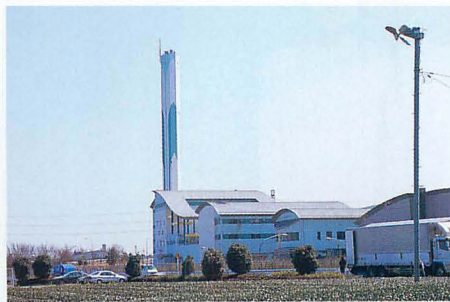
▲送信アンテナは、局舎から2.5kmほど離れた入間市総合クリーンセンターの煙突上の設置されている。地上高85.25m、標高約200mの高さとなるため、非常に広範囲で聴取可能だ。
