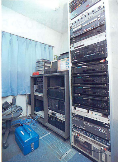
▲「エフエム茶笛」のマスター。CMや録音放送は、中央のラックに納められている自動番組送出装置(DAD)によって、自動的に送り出される。
