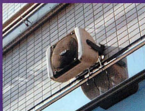
▲放送の音声はこのスピーカーで流される。音量が小さいため、地震発生直後に大型のスピーカーを用意し、大音量で公園に集まっている人向けに流した。
