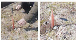
▲早速アース棒を打ち込みます。リグからの線をつないで準備OKです。
