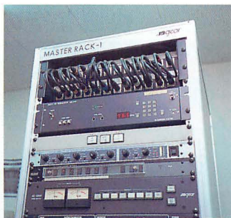
▲手前のラックの最上部に設置されているのは、送信アンテナに送るモジュラーター。入間ケーブルテレビのケーブル回線を使用して、送信アンテナと結ばれている。
