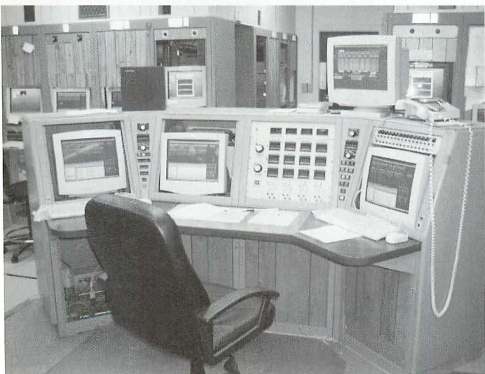
▲写真-9 14台の送信機用の2台の制御卓の一台。夜間も2人で監視するのみ。
