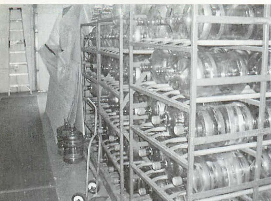
▲写真-7 大電力送信機の冷却に水は必須。水道の故障に備え、大量のポリタンクが準備されている。
