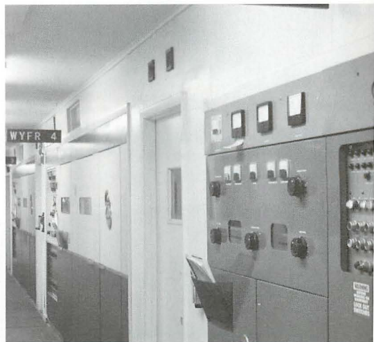
▲写真-6 送信機室の片側にはGATESなどのメーカー製の送信機とともに自家製のものも並んでいる。
